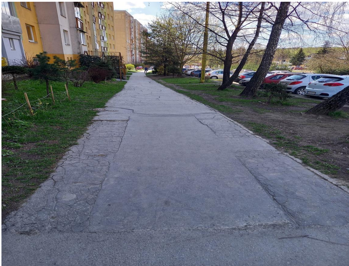
Ul. Sibírska č. 34 až 38 – oprava chodníka na ploche 235 m 2 v predpokladanej cene: 24 447 €
