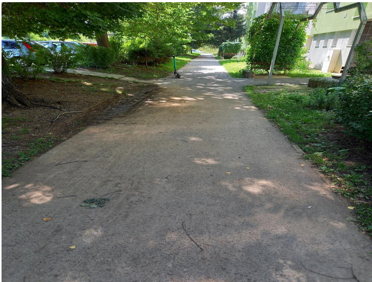
Ul. Pod Táborom č. 31 až 37 – oprava cesty na ploche 732 m 2 v predpokladanej cene: 57 140 €
