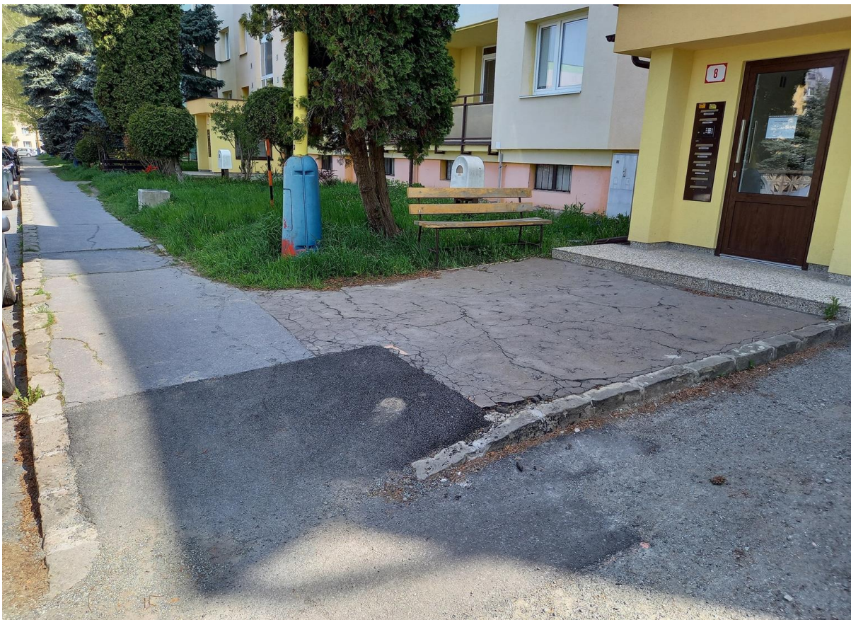
Ul. Pavla Horova č. 1 až 5 – oprava chodníka na ploche 527 m 2 v predpokladanej cene: 48 113 €
