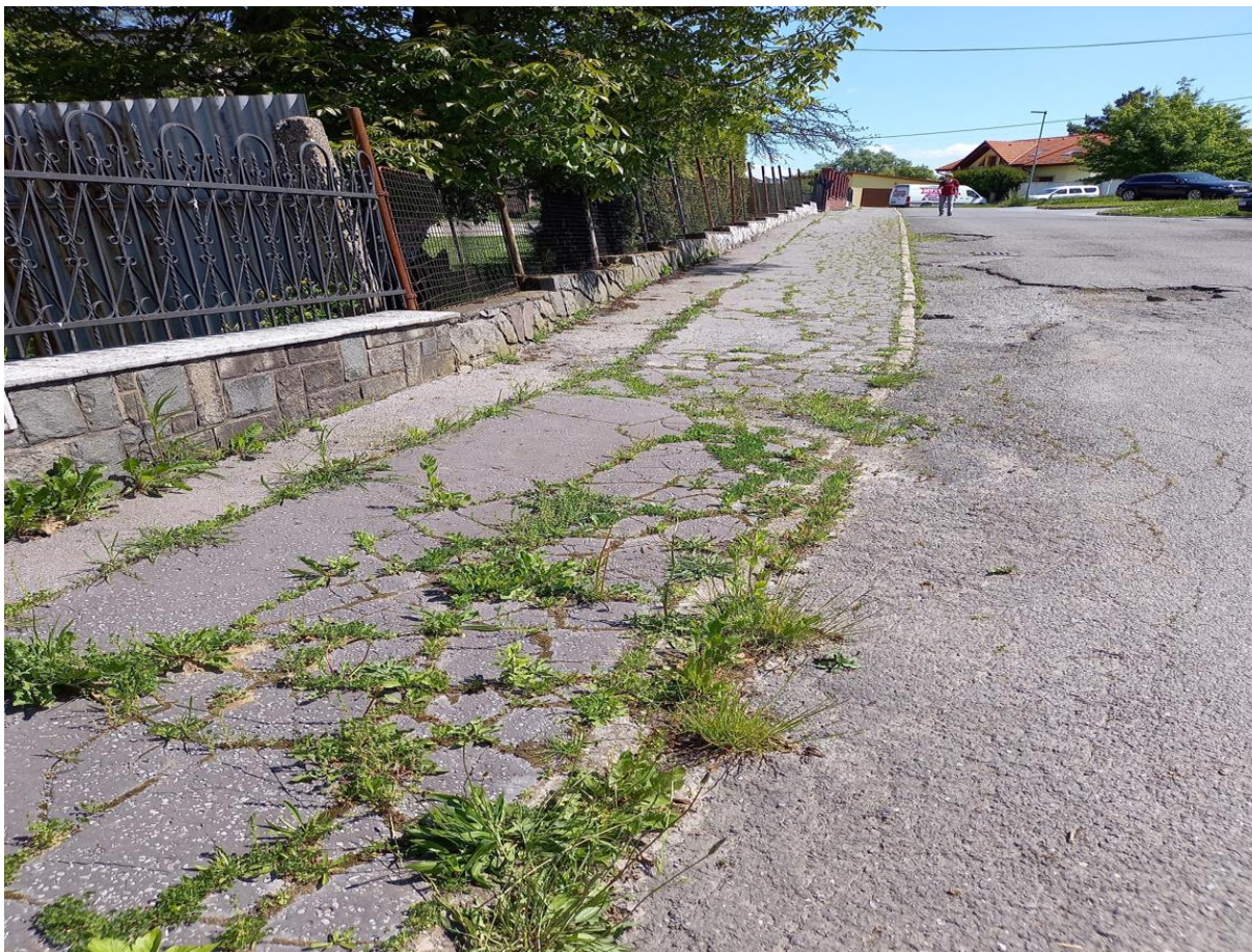
Ul. Kutuzovova č. 3 – oprava chodníka na ploche 74 m 2 v predpokladanej cene: 8 317 €
