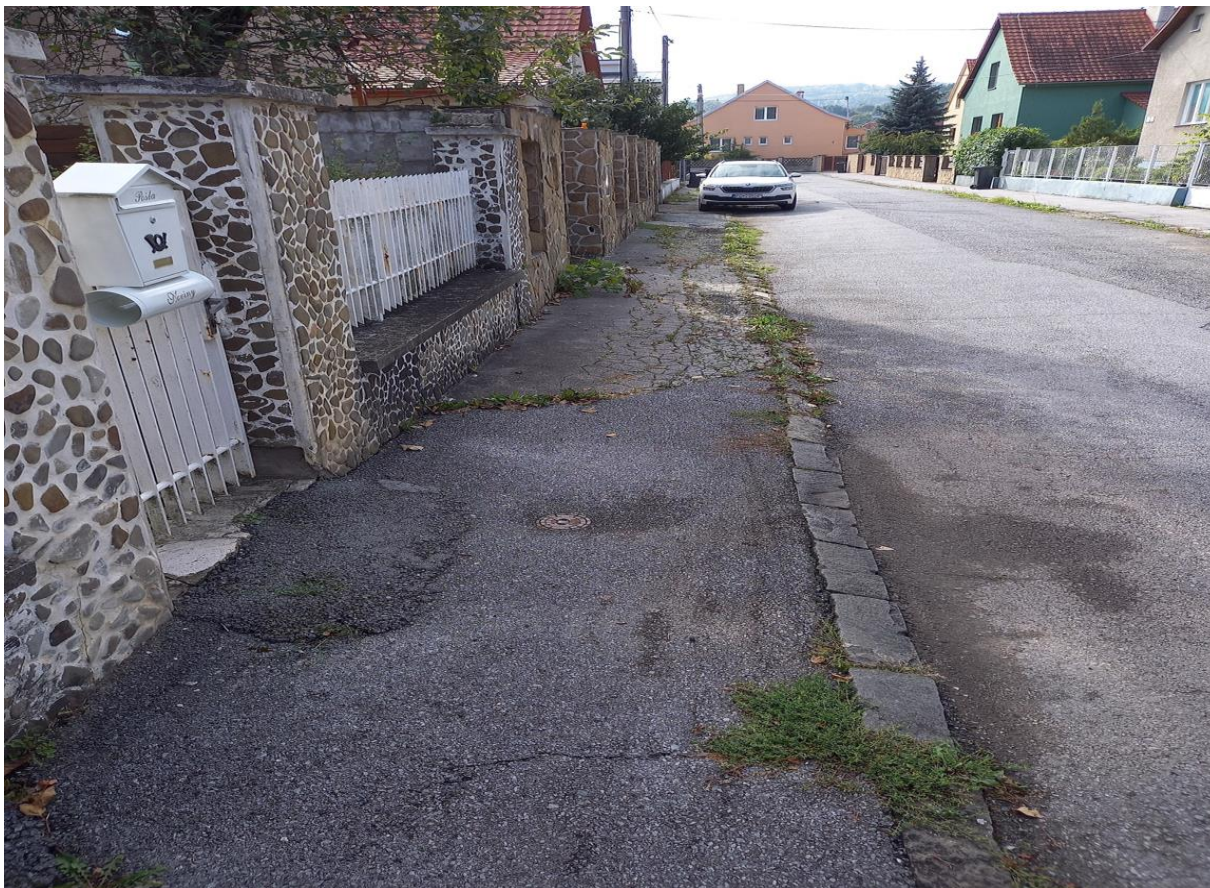
Ul. Petöfiho č. 1 až 37 – oprava chodníka na ploche 312 m 2 v predpokladanej cene: 34 422 €
