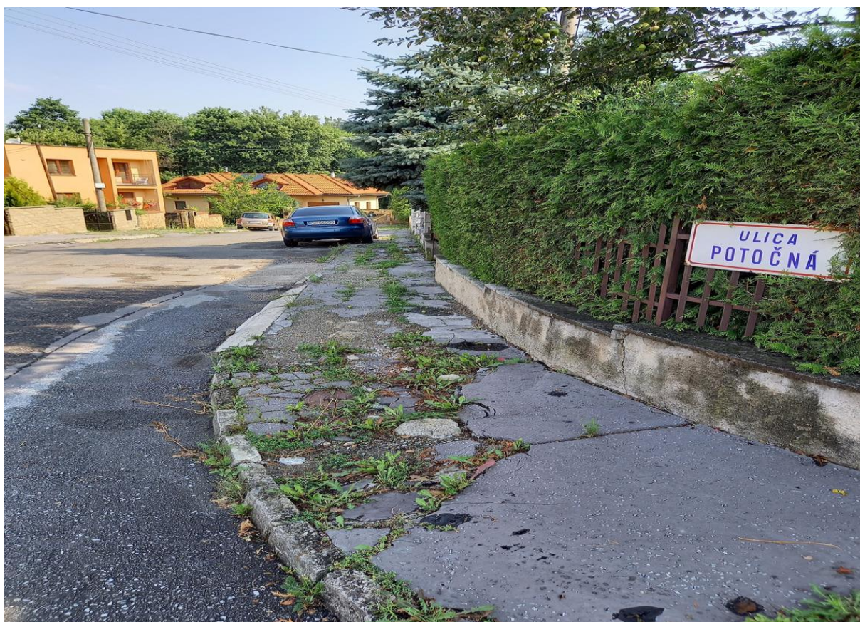
Ul. Orgovánová č. 1 až 31 – oprava chodníka na ploche 526 m 2 v predpokladanej cene: 58 700 €
