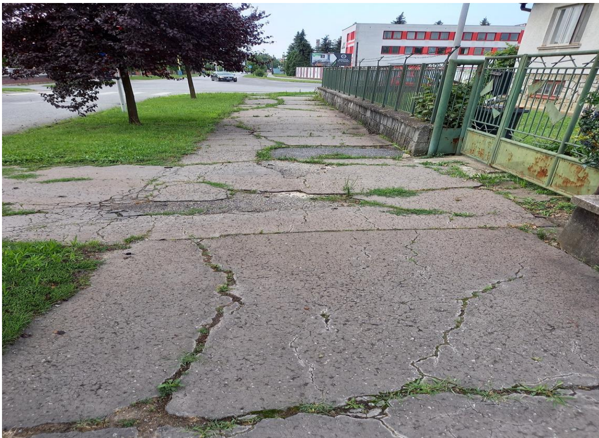
Ul. Fintická č. 1A – oprava chodníka na ploche 181 m 2 v predpokladanej cene: 19 741 €
