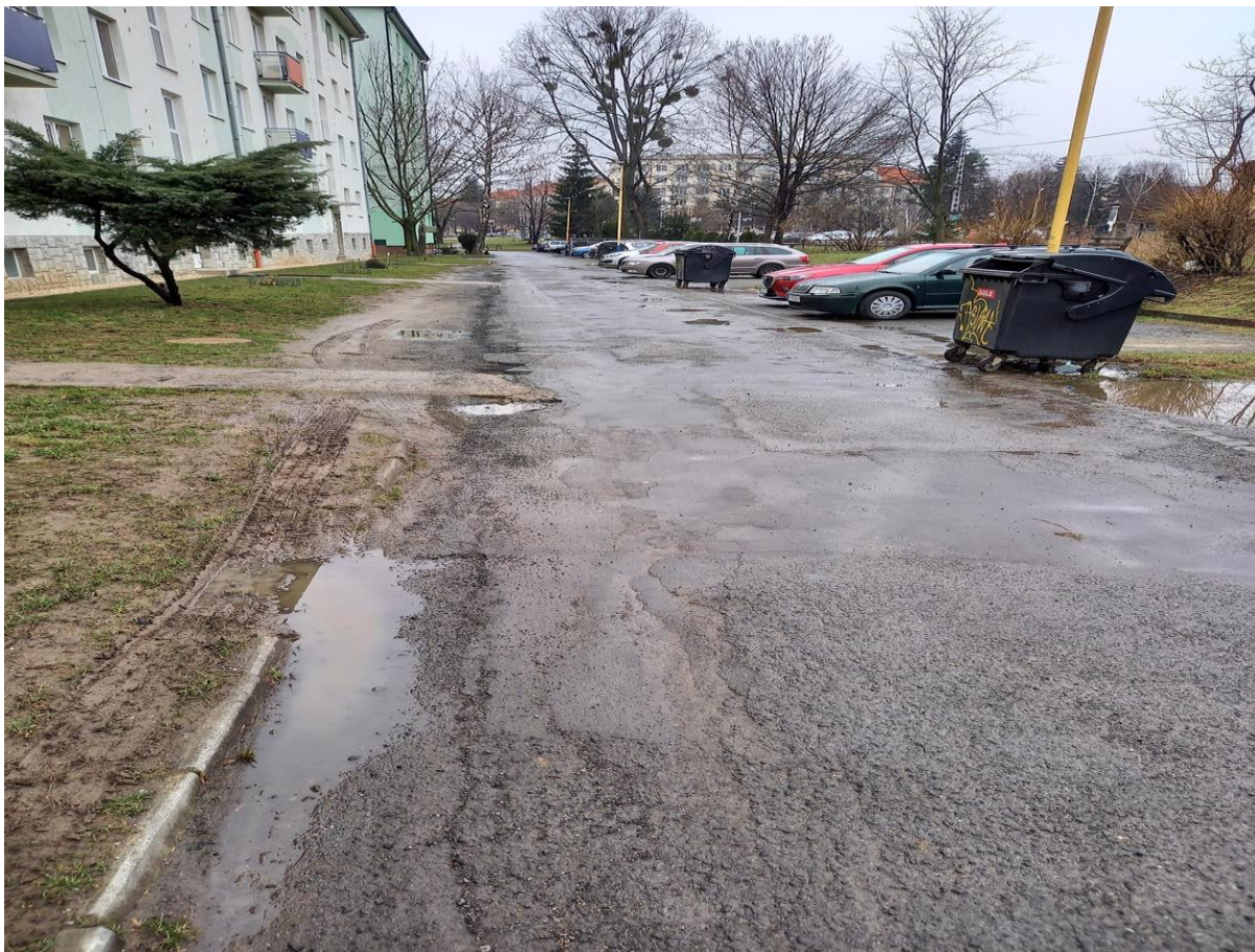
Ul. Tarasa Ševčenka č. 1 až 21 – oprava chodníka na ploche 1430 m 2 v predpokladanej cene: 103 936 €
