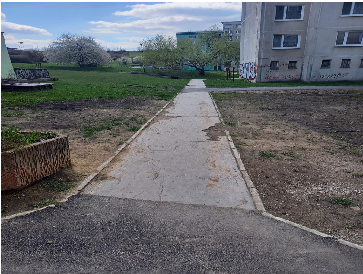
Ul. Sibírska č. 21 až 25 – oprava chodníka na ploche 339 m 2 v predpokladanej cene: 38 157 €
