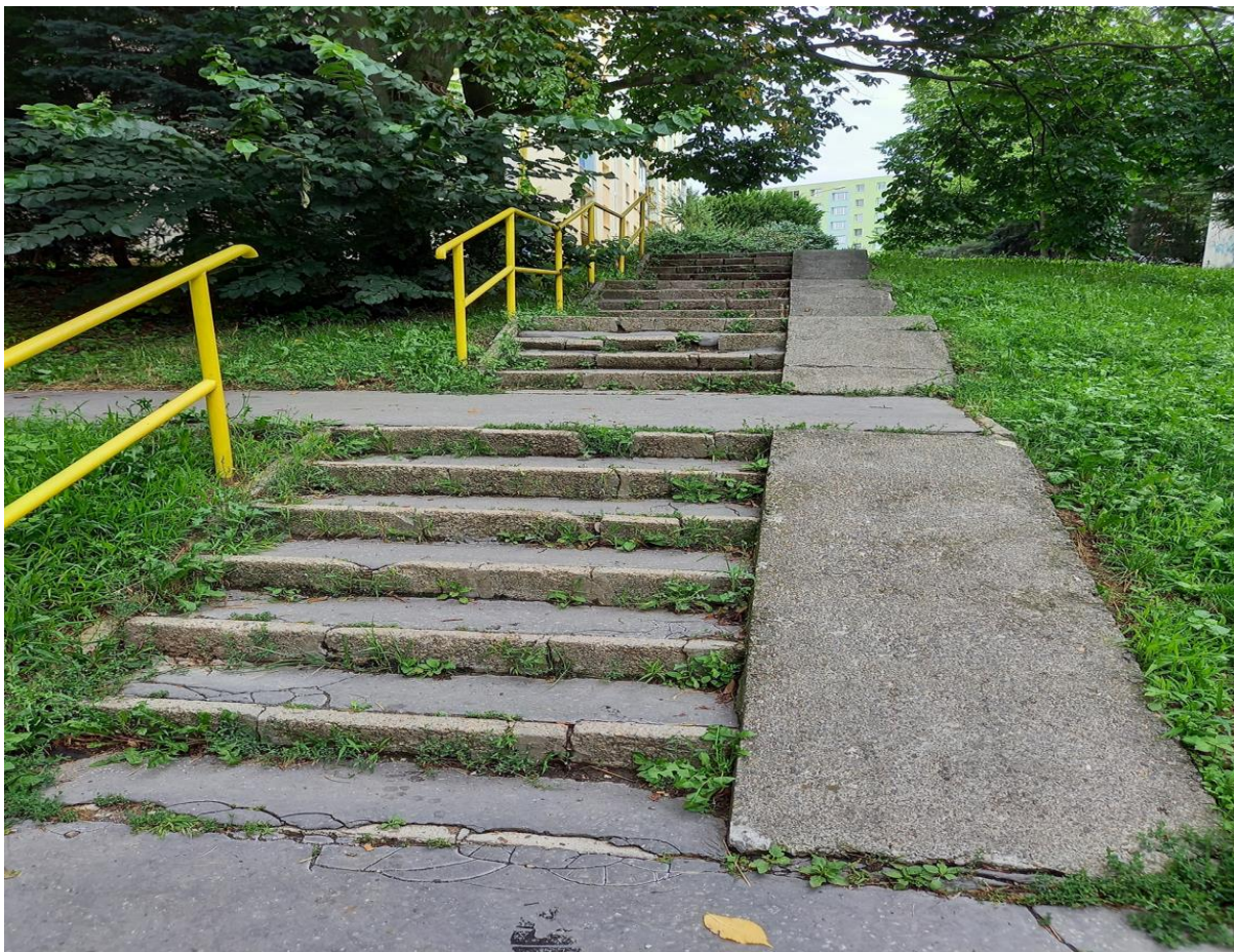
Ul. Zimná č. 2 až 12 – oprava chodníka na ploche 377 m 2 v predpokladanej cene: 34 998 €
