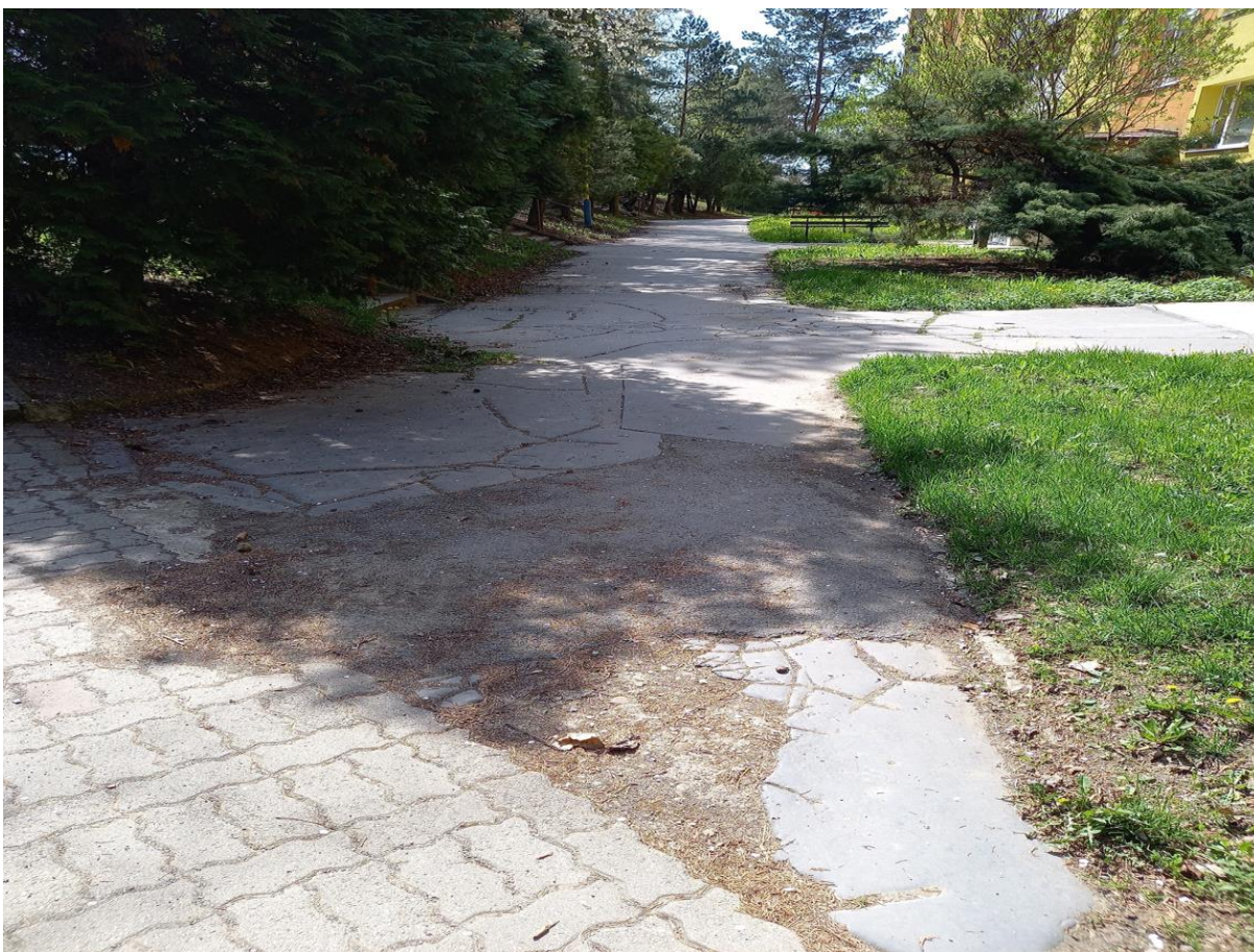
Ul. Dubová č. 2 až 10 – oprava cesty a parkoviska na ploche 1960 m 2 v predpokladanej cene: 96 744 €
