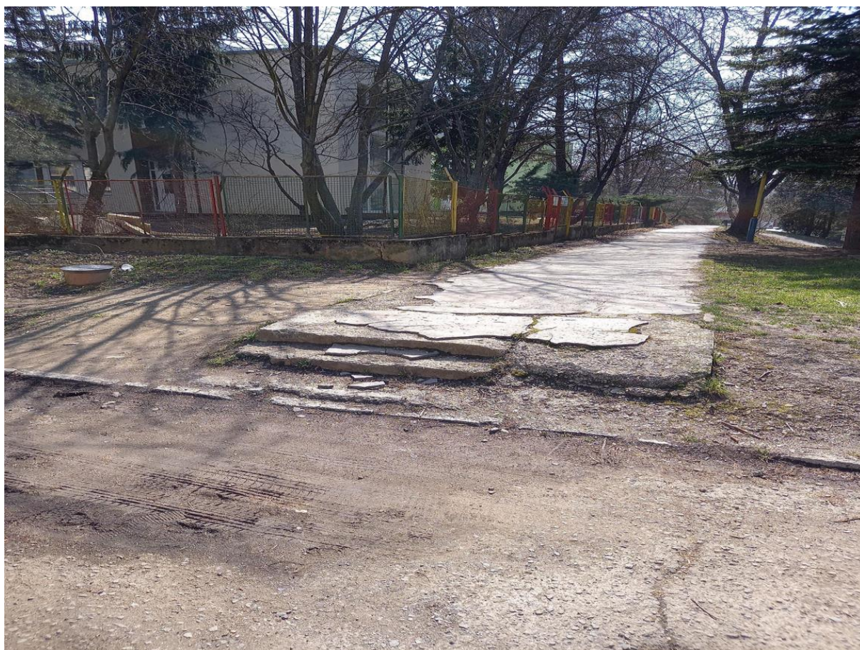
Ul. Arm. Gen. Svobodu č. 26 – oprava schodov na ploche 20 m 2 v predpokladanej cene: 2 161 €
