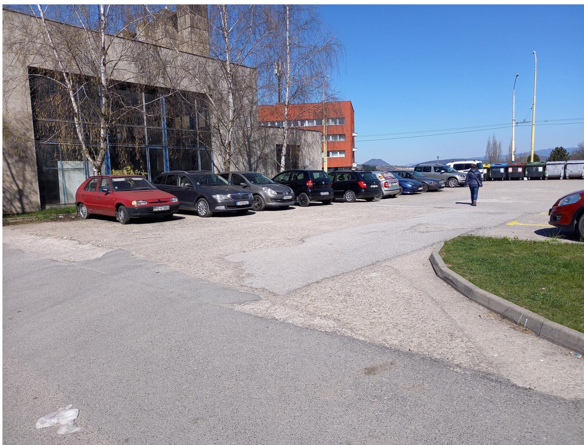
Ul. L. Novomestského č. 2 až 10 – oprava chodníka na ploche 364 m 2 v predpokladanej cene: 37 444 €
