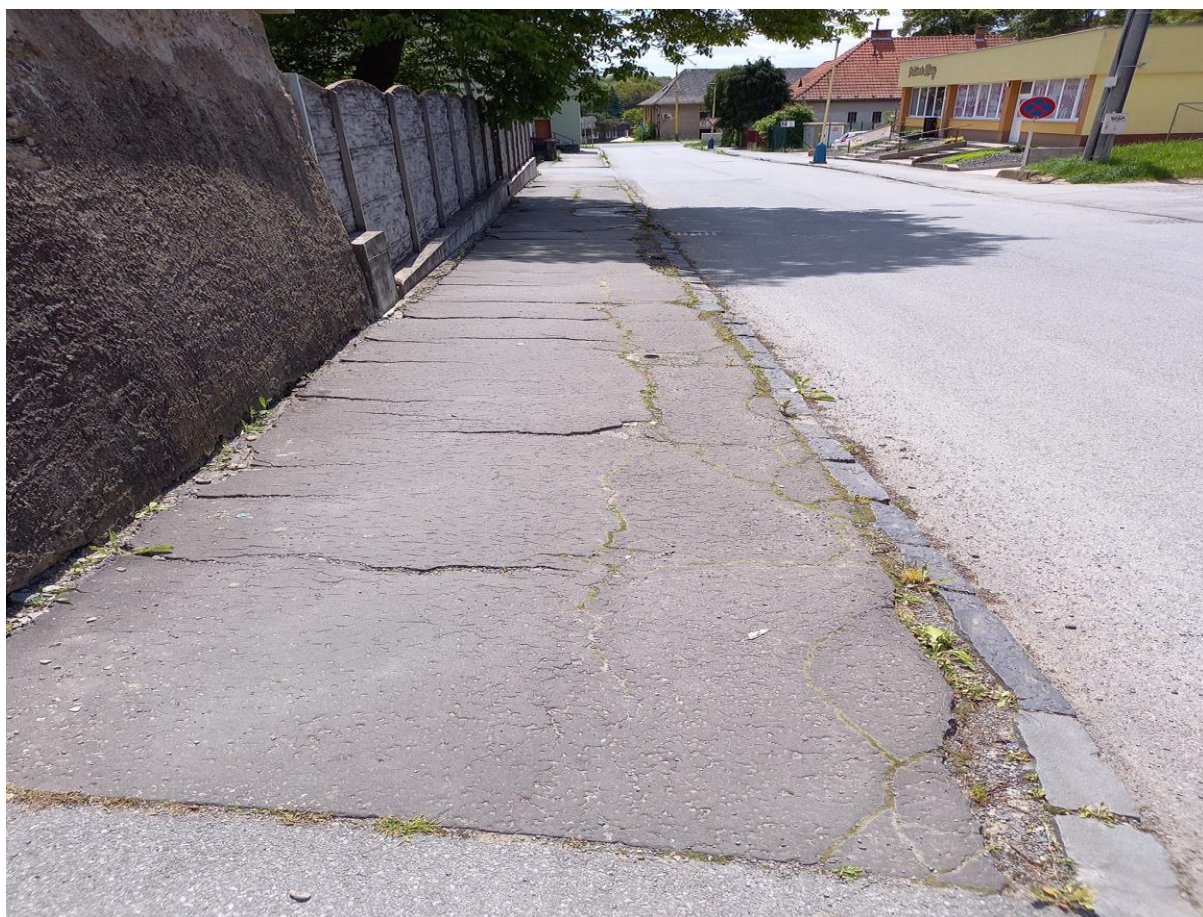
Ul. Kutuzovova č. 5 – oprava chodníka na ploche 240 m 2 v predpokladanej cene: 22 304 €
