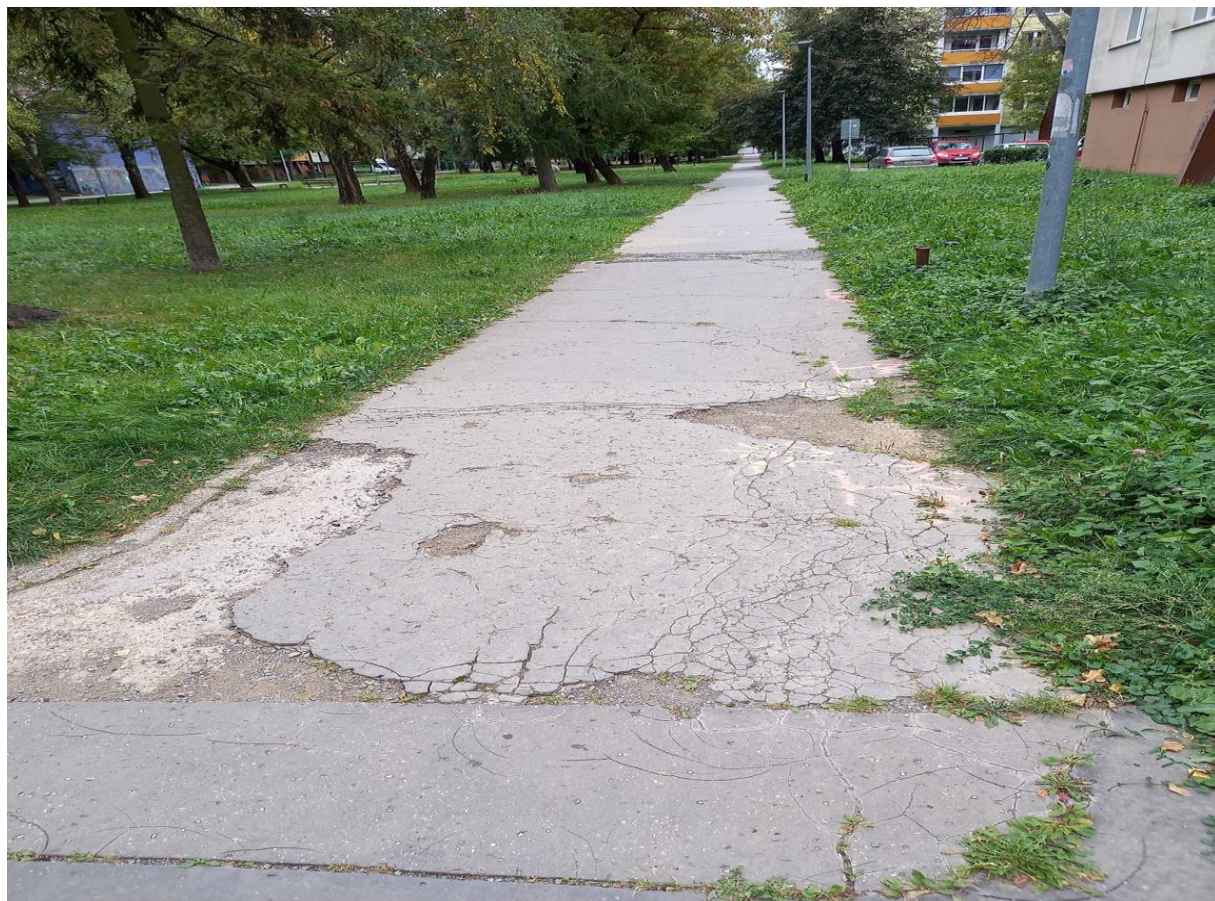
Ul. Mukačevská - ľavá strana smerom na ul. Jazdecká – oprava chodníka na ploche 378 m 2 v
