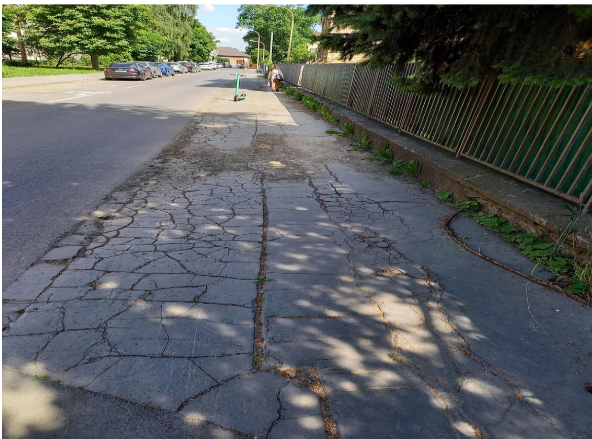
Ul. Slovenská č. 12 – oprava chodníka na ploche 191 m 2 v predpokladanej cene: 16 226 €
