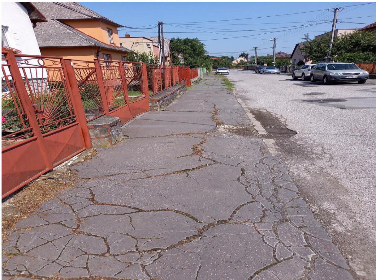
Ul. Marka Čulena č. 42 až 50 – oprava cesty na ploche 520 m 2 v predpokladanej cene: 48 432 €
