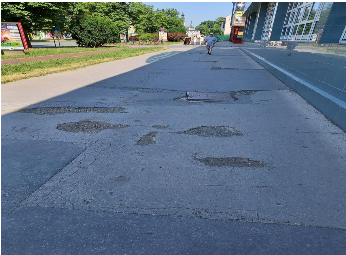
Ul. Košická č. 2D a ul. Východná č. 19A až 21 – oprava chodníkov na ploche 420 m 2 v predpokladanej
