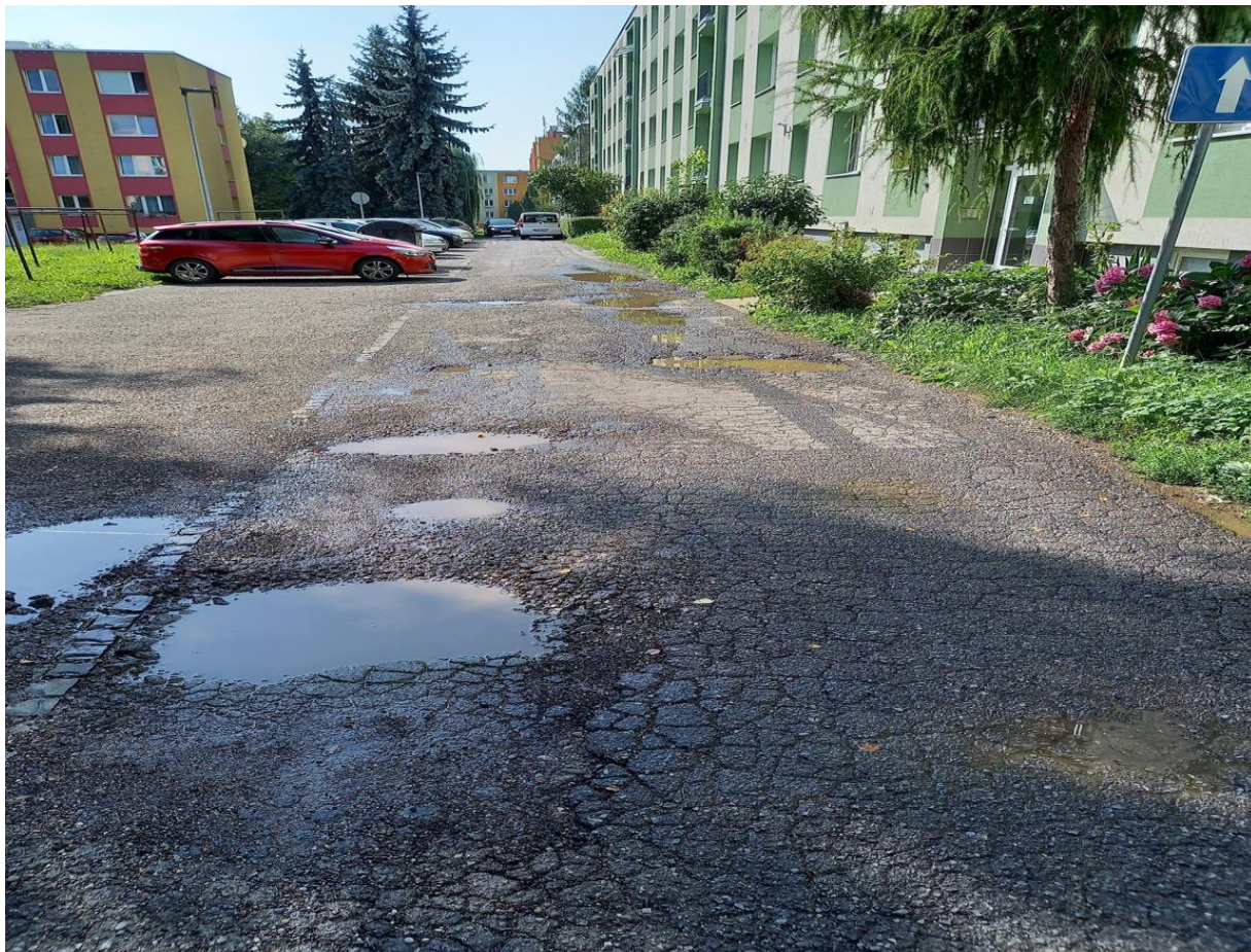
Ul. Pod Kamennou baňou č. 60 až 88 – oprava chodníka na ploche 654 m 2 v predpokl. cene: 80 129 €
