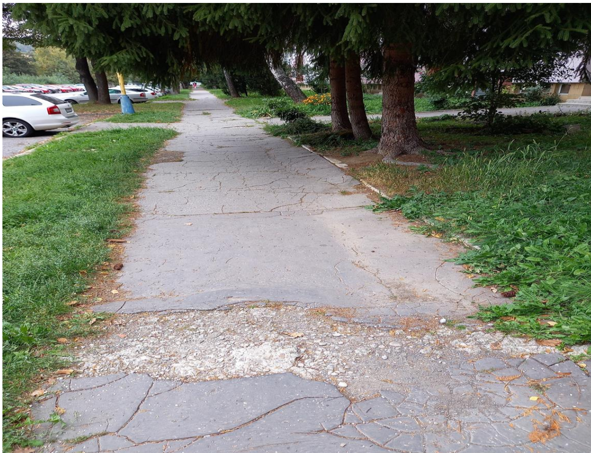
Ul. Prostějovská č. 5 až 7 – oprava chodníka na ploche 394 m 2 v predpokladanej cene: 42 781 €
